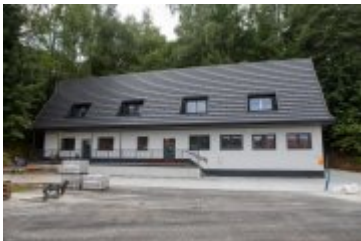
• 2020-08-06-Postępy prac na stadionie miejskim
