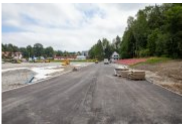
• 2020-08-06-Postępy prac na stadionie miejskim
