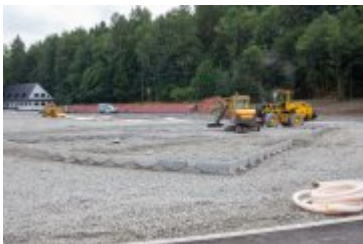
• 2020-08-06-Postępy prac na stadionie miejskim
