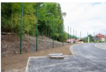
• 2020-08-06-Postępy prac na stadionie miejskim
