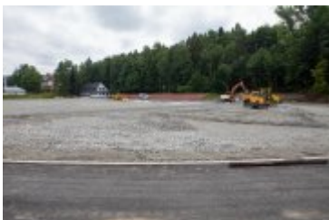
• 2020-08-06-Postępy prac na stadionie miejskim
