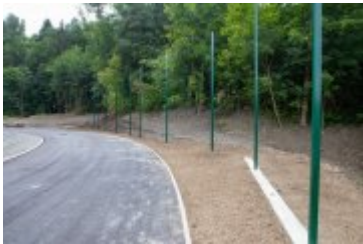
• 2020-08-06-Postępy prac na stadionie miejskim
