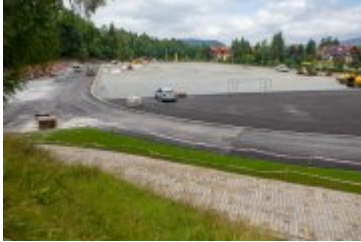
• 2020-08-06-Postępy prac na stadionie miejskim
