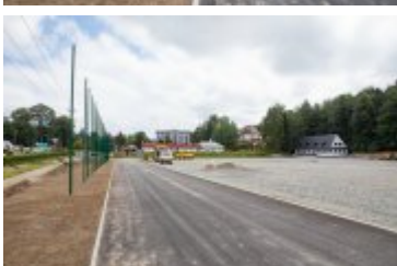
• 2020-08-06-Postępy prac na stadionie miejskim
