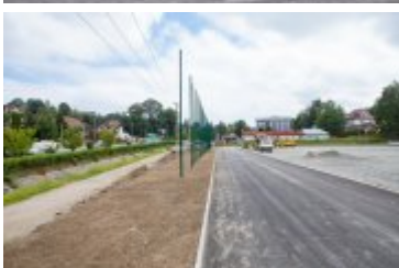
• 2020-08-06-Postępy prac na stadionie miejskim
