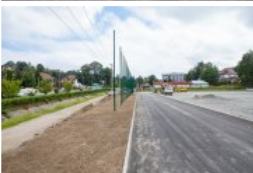
• 2020-08-06-Postępy prac na stadionie miejskim
