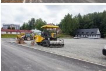
• 2020-08-06-Postępy prac na stadionie miejskim
