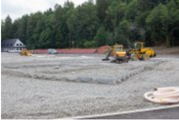
• 2020-08-06-Postępy prac na stadionie miejskim
