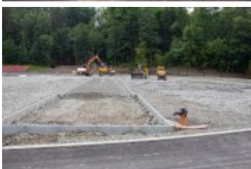
• 2020-08-06-Postępy prac na stadionie miejskim
