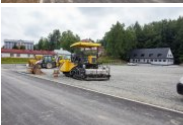
• 2020-08-06-Postępy prac na stadionie miejskim
