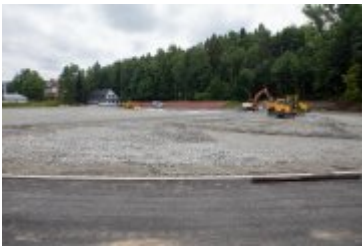
• 2020-08-06-Postępy prac na stadionie miejskim
