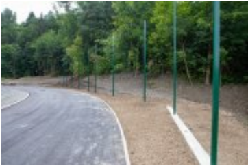
• 2020-08-06-Postępy prac na stadionie miejskim
