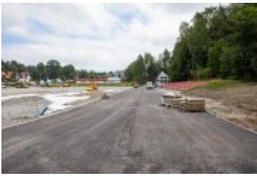
• 2020-08-06-Postępy prac na stadionie miejskim
