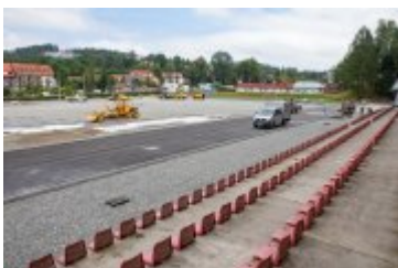
• 2020-08-06-Postępy prac na stadionie miejskim
