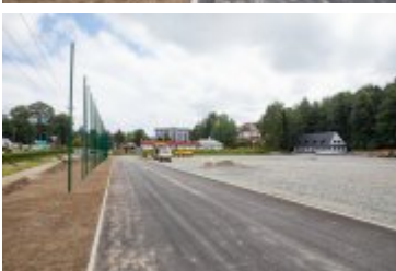
• 2020-08-06-Postępy prac na stadionie miejskim
