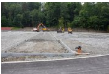
• 2020-08-06-Postępy prac na stadionie miejskim
