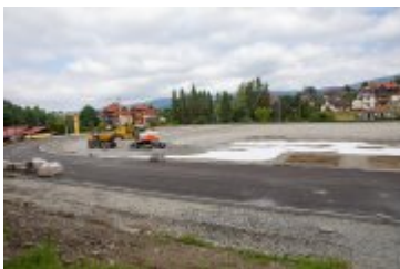
• 2020-08-06-Postępy prac na stadionie miejskim
